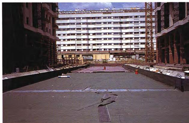
Arriba, imagen de la impermeabilización de la cubierta del garaje. Abajo, de izquierda a derecha, una vista del jardín desde uno de los portales y pasarela sobre un estanque.
